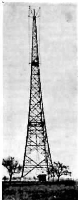
Joon. 3. Saksa Lorenz-Hahnemanni süsteemiline puust torniga antenn Frankfurdis, M. ä.
