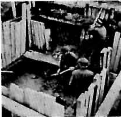
Joon. 5. Vundamendi kaeviku valmistamine Türi masti jaoks.
