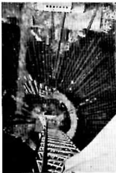
Joon. 9. Mast kõige huvitavas perspektiivis — tipust alla vaadatuna. Maapinnal on selgesti näha maaühenduse juhtmete kraavid ja masti toitejuhtmed saatja ja masti vahel.
