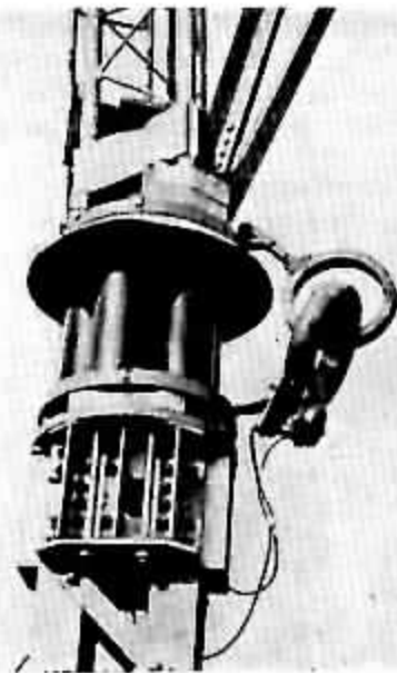
Joon. 11. Oksa isolatorite grupe ja masti valgustuse transformator.
