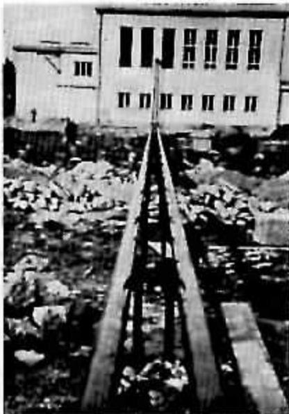
Joon. 13. Masti toitejuhtmed (federid). Punasest vasest jämeda toru sees on umbes sõrmejämedune portsellaan isolaatoritel kantud toitejuhe.
