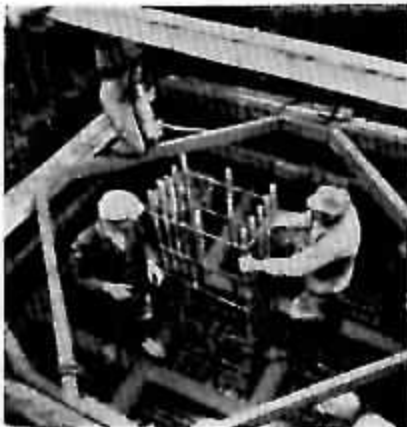
Joon. 6. Türi saatejaama masti aluse raudkanduse valmistamine.
