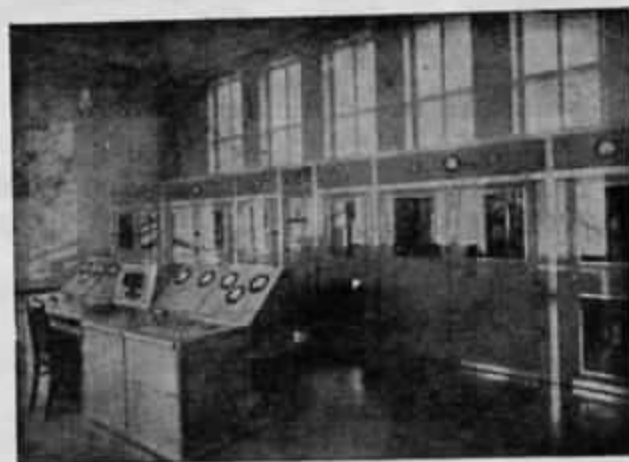
Joon. 10. Türi saatejaama saateaparatuur. Esiplaanil kontrollpult; keskel kvartsujuhtsaatja; vasakul madalsagedusvõimendi; paremal kõrgsagedusastmed ja lõppaste.
