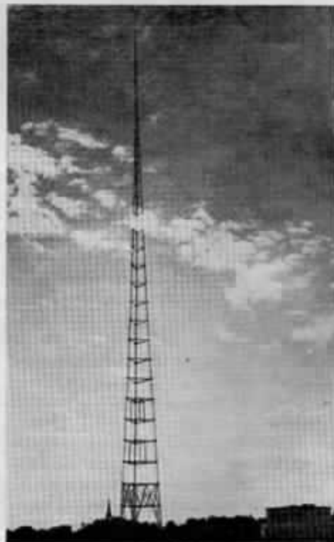
Joon. 5. 196 m kõrgune Türi saatejaama mastantenn. All paremal saatehoone, tagaplaanil Türi kirik.
