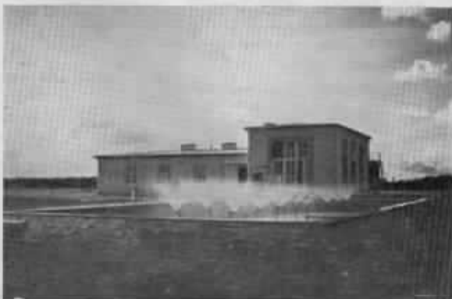
Joon. 12. Diiselmaja ühes jahutustüübiga. Purrakkaevud võimaldavad paremat jahutust.
