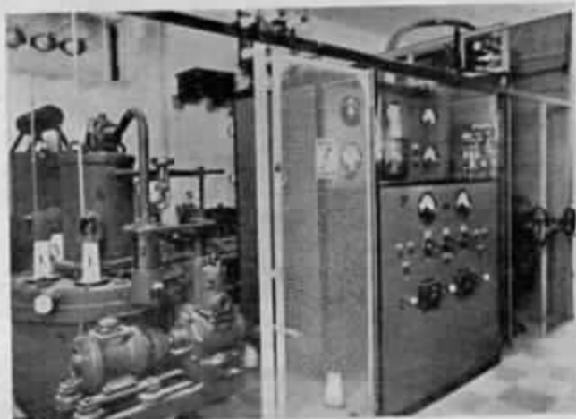
Joon. 7. Türi saatejaama kõrgpingealadi ehk mutaatori: 1 — anoodi isolatorid, 2 — kõrgvaakuumpump, 3 — eelvaakuumpump, 4 — mutaatori kere, 5 — süütamist jaotav mootor, 6 — kaitsesein, 7 — jaotuskilp vaakuumimõõtjaga, galvanomeetriga jne.
