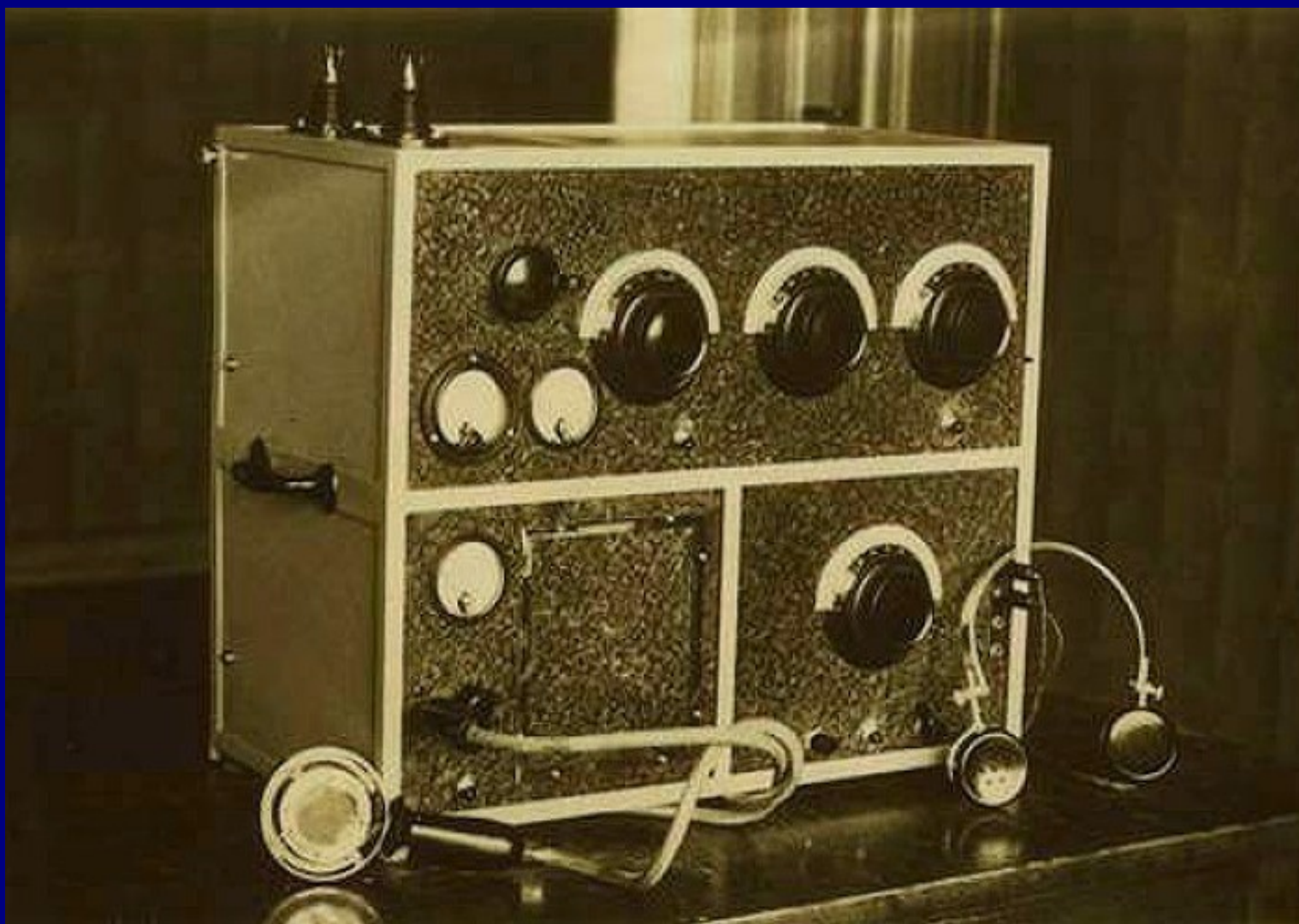
ES5F - Arnold Isotamme ja ES6C - Vitali Suigusaare 1935. aastal konstrueeritud ja ehitatud mobiilne lühilaine raadiojaam.
