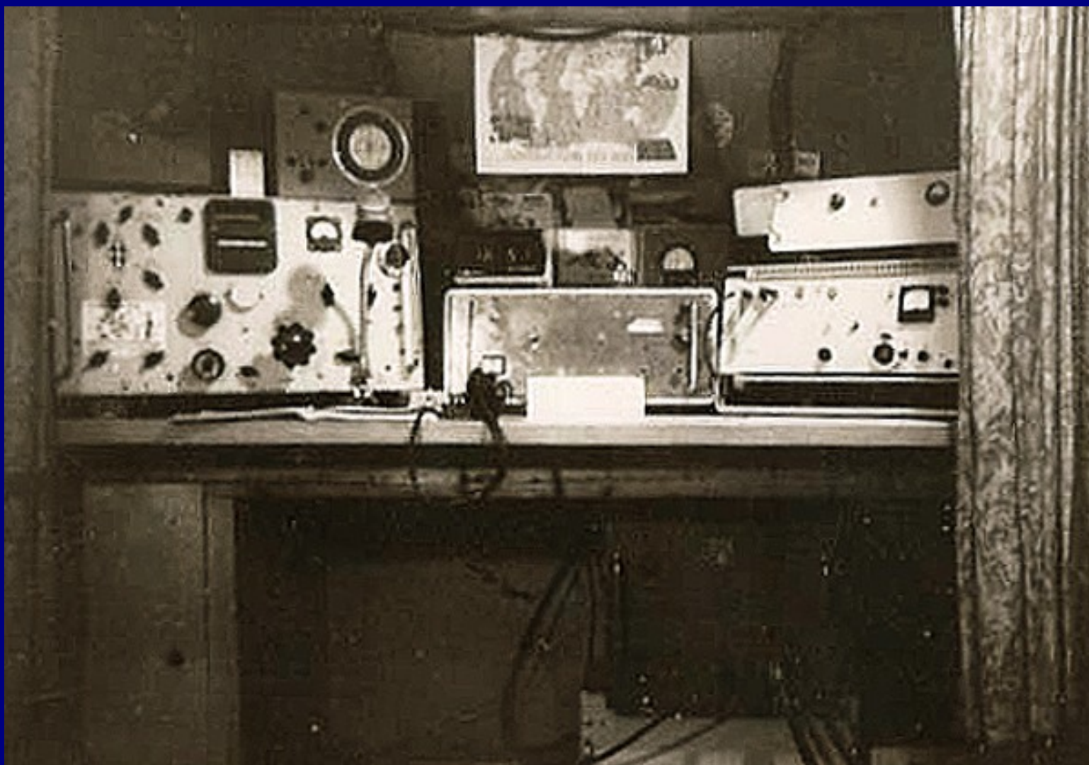
UR2JL - Aarne Pajuste KROT-i baasil ehitatud HF transiiver ning 2 m ja 70 cm transverterid 1980. aastal.
